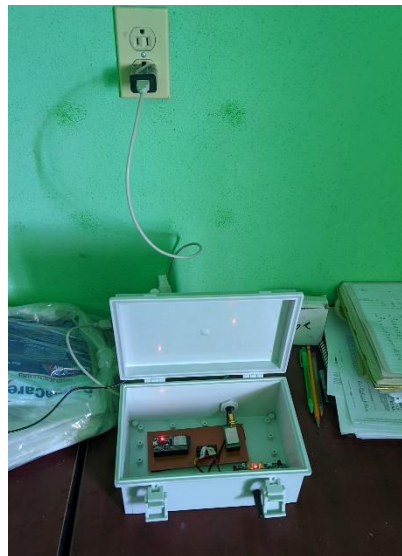
Figura 22 Puerta de enlace instalada.
