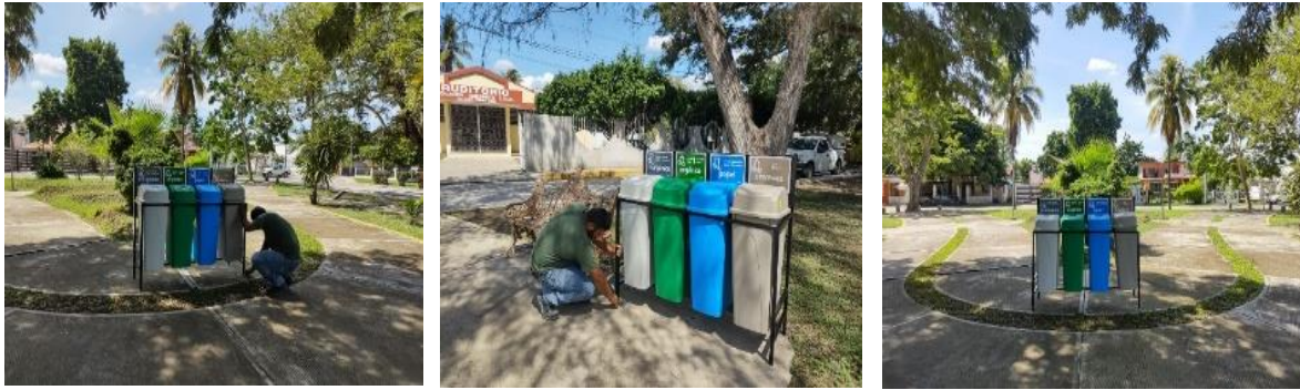
Figura 6. Instalación de los contenedores clasificadores
