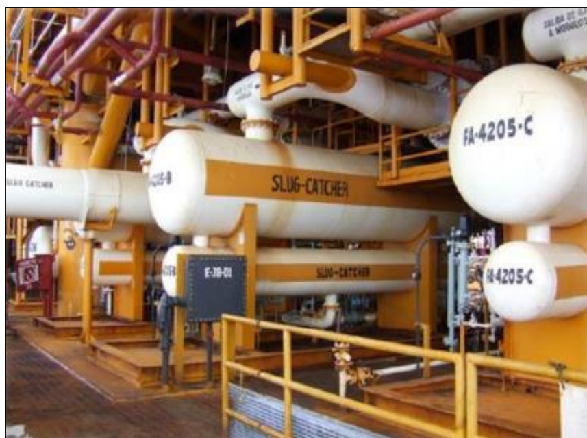
Figura 1.24 Separadores de gas amargo Slug Catcher en Abkatun-A Compresión.
