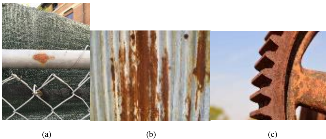
Figura 18. Imágenes de Corrosion_Data.
