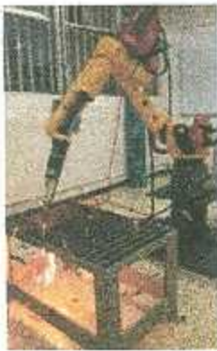
4. Fin de soldadura
