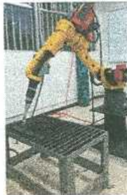
2. Punto de inicio de soldadura
