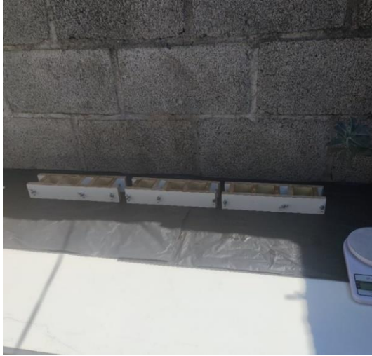
Imagen 20. Moldes colocados en una superficie plana y nivelada.
