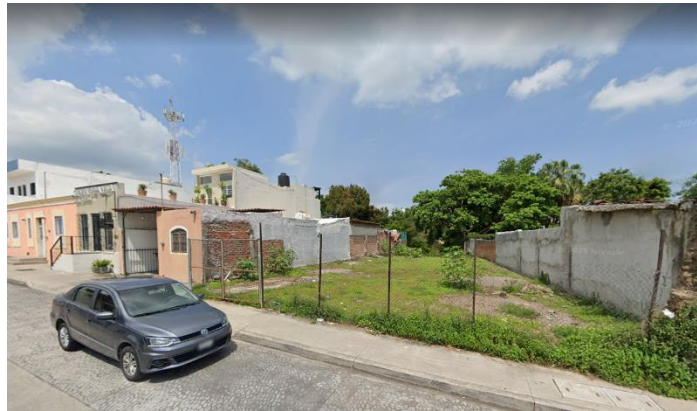
Figura 10. Calle Constitución #284, Colima, Centro
