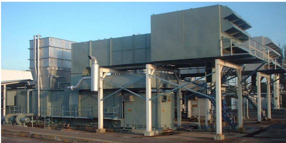
Figura 2. Turbogeneradores de la planta eléctrica
