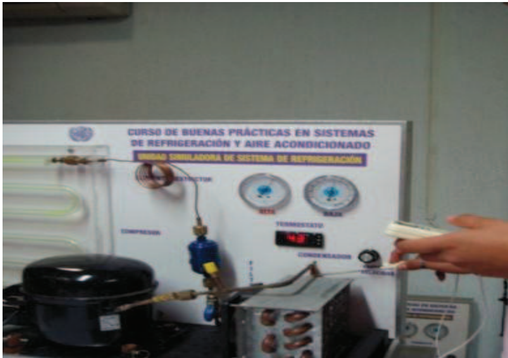
Figura 3.13. Midiendo la temperatura de salida en el condensador
