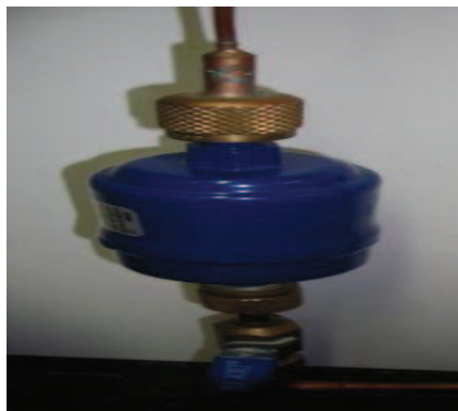
Figura 3.5. Filtro de refrigerante.
