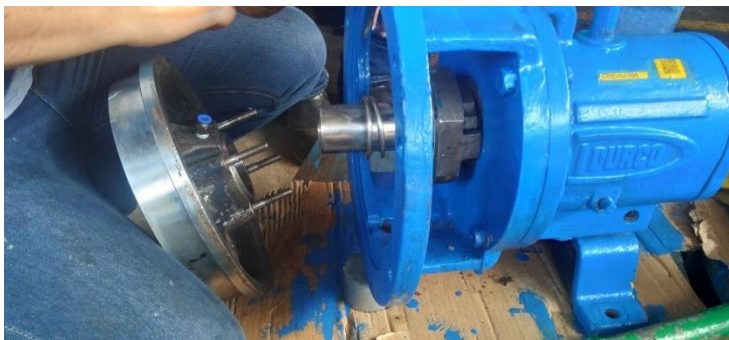
Ilustración 9. Desmontado de sello e impulsores fuente: propia
