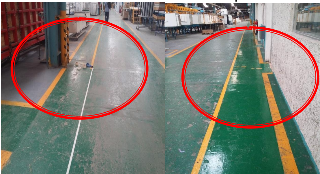
Ilustración 27. Antes y después de pintar pasillos Fuente: propia
