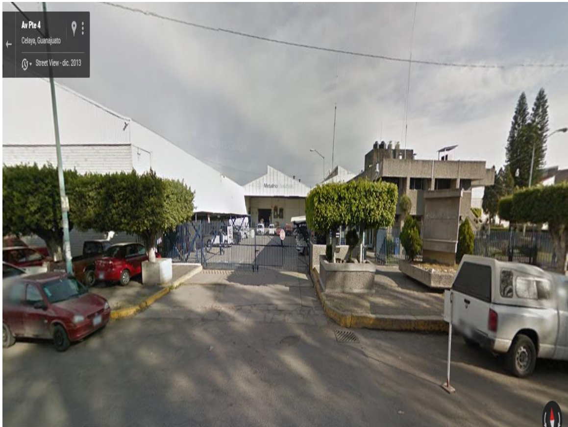
Ilustracion 1. Empresa Metalfrío Solutions
