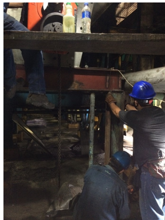
Figura 4-44.: Instalación de vigas de carga para bastidor: segunda sección transportador helicoidal.
