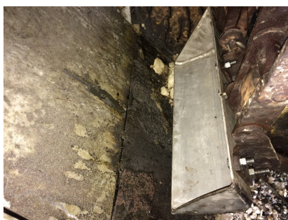
Figura 4-55.: Vista de caída de azúcar del transportador helicoidal al elevador enfoque en el cangilón.
