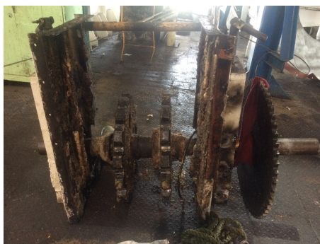
Figura 4-9.: Retiro de sprockets de parte alta del elevador de azúcar húmeda.
