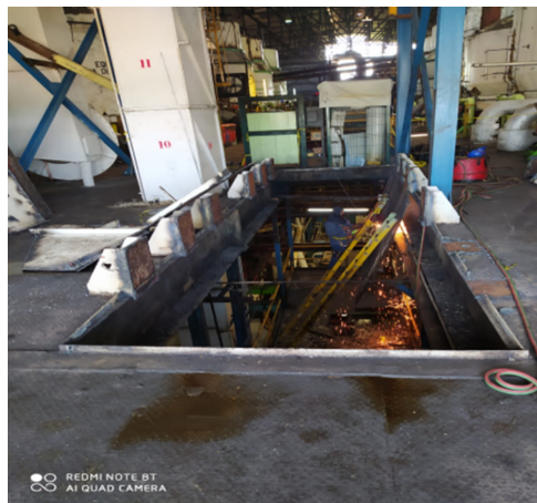
Figura 4-16.: Retiro de tolvas de azúcar.
