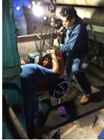
Figura 4-51.: Instalación de transmisión Tipo: Falk 2090 Y2 (Plan B), Primera sección transportador helicoidal.
