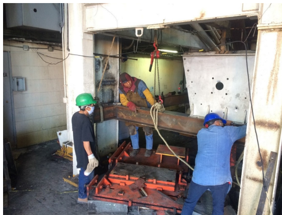
Figura 4-40.: Instalación de vigas de carga para bastidor primera sección transportador helicoidal.
