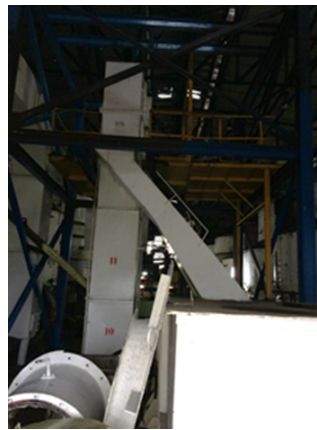
Figura 4-12.: Desmontaje de cajones de Elevador de azúcar húmeda.
