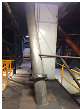
Figura 4-31.: Tubo de caída de azúcar ubicado en secador 2.
