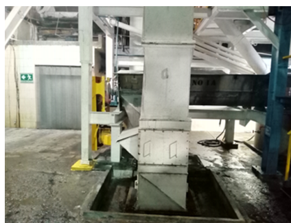
Figura 4-25.: Instalación de tapas parte inferior del elevador de azúcar húmeda.
