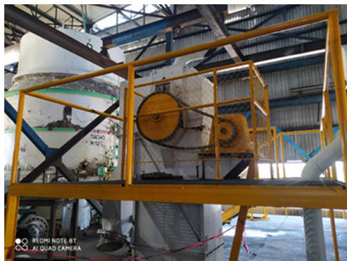
Figura 4-26.: Armado de la parte superior del elevador de azúcar húmeda.
