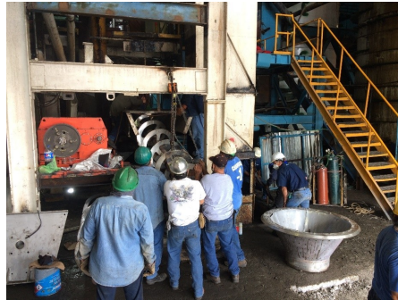
Figura 4-45.: Instalación de listones helicoidales, flechas intermedias y soportes internos.
