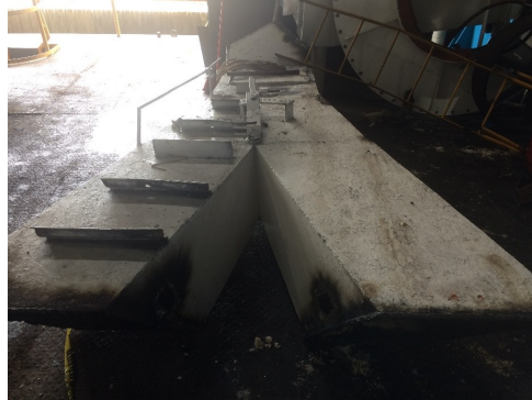
Figura 4-14.: Eliminación de garganta bipartida.
