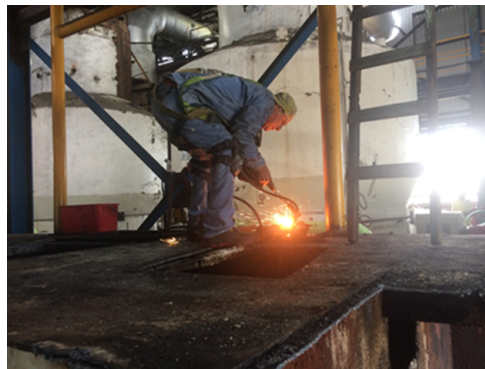
Figura 4-15.: Retiro de tolvas de azúcar.
