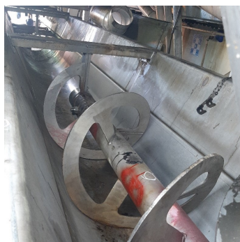
Figura 4-37.: Desinstalación de listones helicoidales, soportes intermedio y flechas intermedias.
