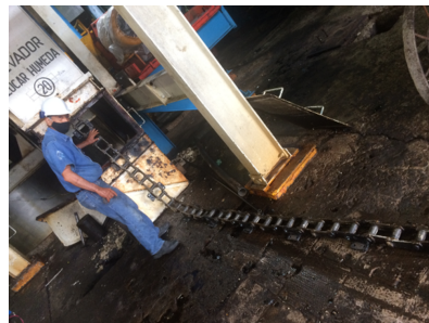
Figura 4-7.: Desmontaje de cadena de elevador de azúcar húmeda.
