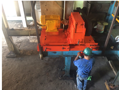
Figura 4-35.: Ubicación de transmisión antes de la mejora.
