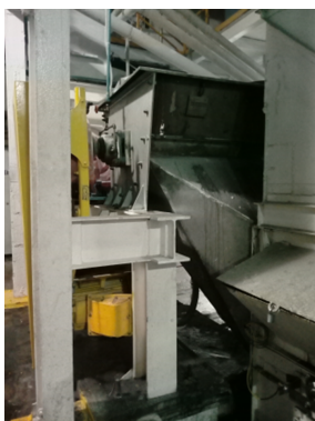
Figura 4-56.: Caída de azúcar del transportador helicoidal al elevador (terminada).
