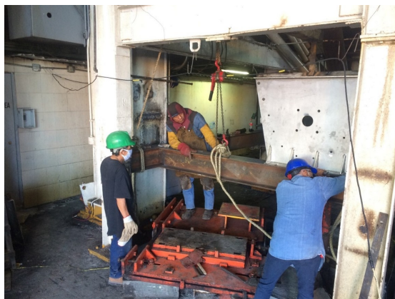
Figura 4-41.: Bastidor terminado primera sección transportador helicoidal.
