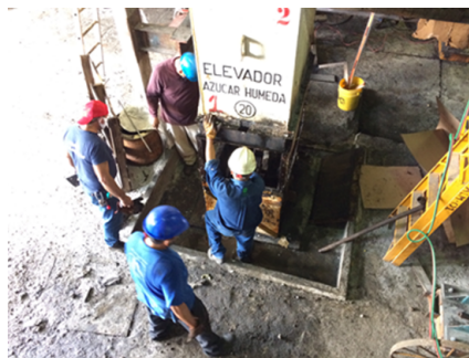
Figura 4-24.: Instalación de cadena y cangilones.
