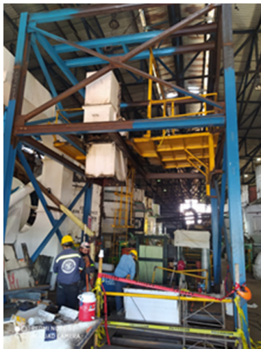
Figura 4-8.: Retiro de cajones de elevador parte superior.[Saquimux, 2004]
