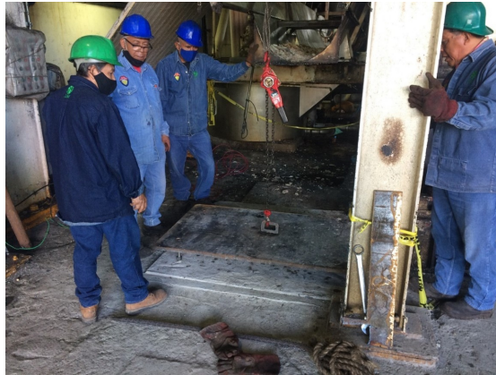
Figura 4-39.: Instalación de placa base de soporte de bastidor de carga transportador helicoidal primera sección.
