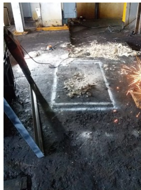
Figura 4-19.: Área de posición de monolito Elevador y Transportador.
