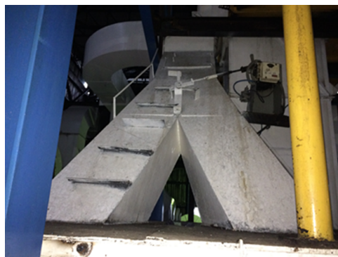
Figura 4-13.: Desmontaje de garganta bipartita.
