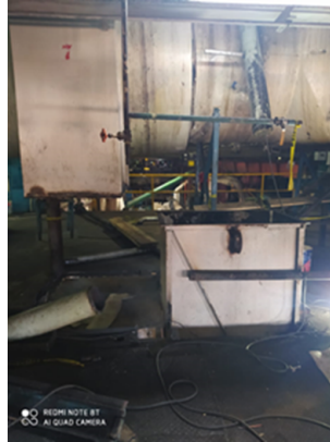
Figura 4-11.: Retiro de cajones de Elevador de azúcar en el piso de secadores
