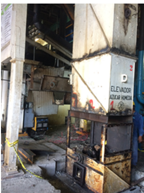
Figura 4-21.: Instalación de primeros cajones del elevador a la base.
