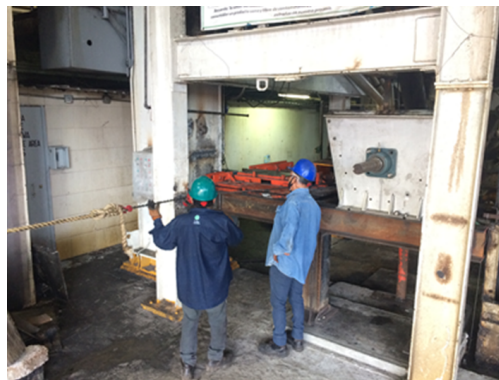
Figura 4-46.: Instalación de tapa de artesa, flecha principal y chumacera de pared.
