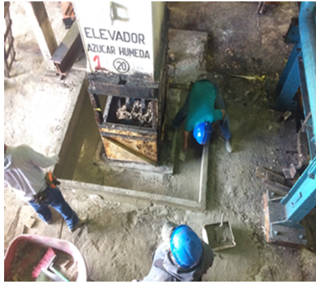
Figura 4-23.: Instalación de flechas internas y sprockets dentro del elevador de azúcar húmeda.
