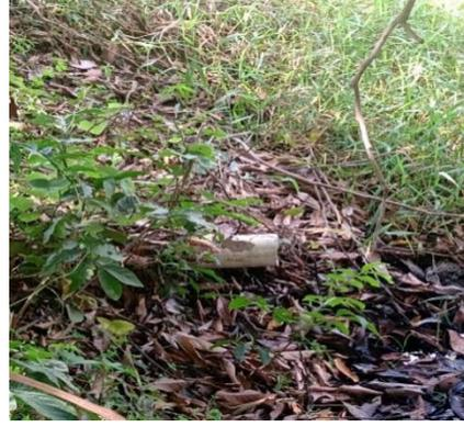
**Figura 2. Tubería de descarga en mal estado**
