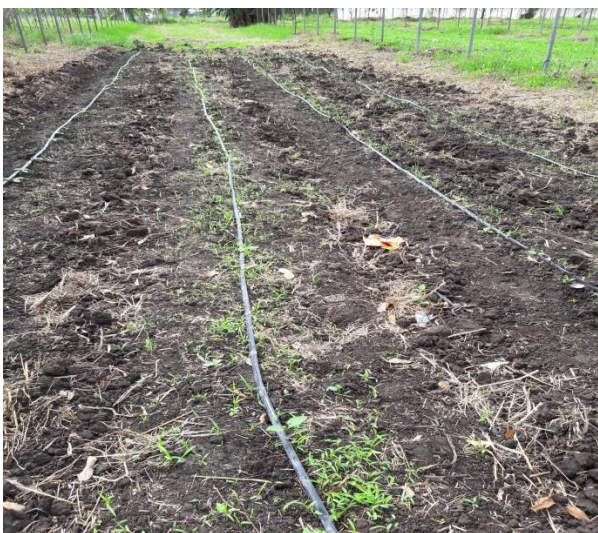
Imagen 3. Instalación del sistema de riego por goteo para el cultivo de melón.
