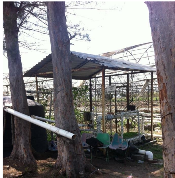
Imagen 8. Caseta del sistema de riego.
