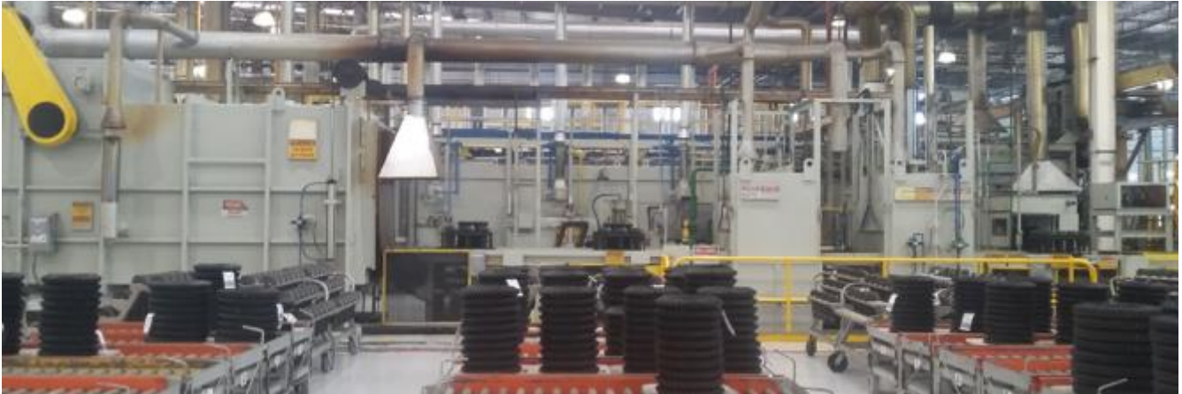
Fig. 8. Imagen del Horno de tratamientos térmicos de la planta Meritor Manufacturing.
