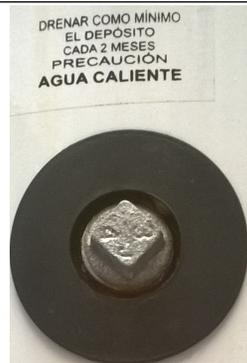
Figura C.1: Tapón de drenado de un depósito de agua caliente.
