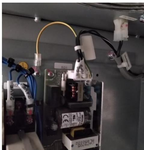
Imagen 38: RG1 en panel lateral en la unidad HD (DC).
