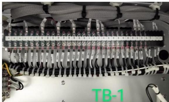
Imagen 16: TB-1 Ubicado en el panel trasero de la máquina.
