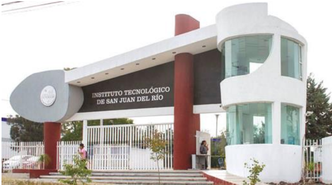
Figura 1 Fachada principal del ITSJR.
