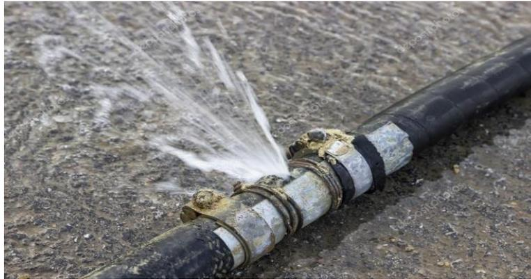
**Figura 1.** Tubería dañada por exposición ambiental.
