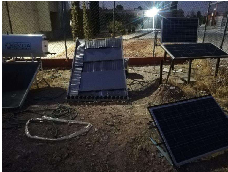
Figura 5.5 “Equipo solar instalado”
