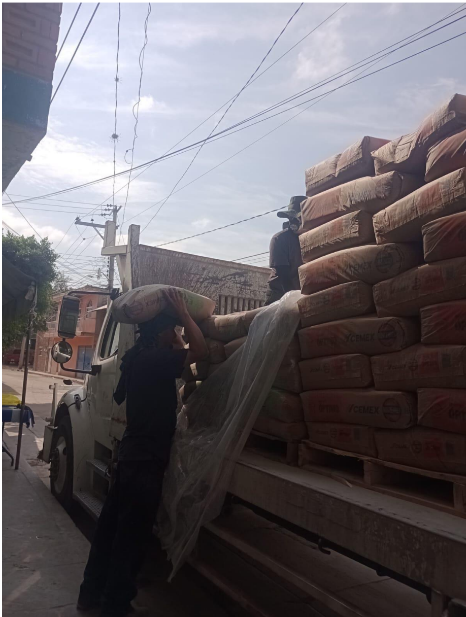
Ilustración 42 Descarga de sacos de cemento antes de la implementación de las medidas de seguridad e higiene
