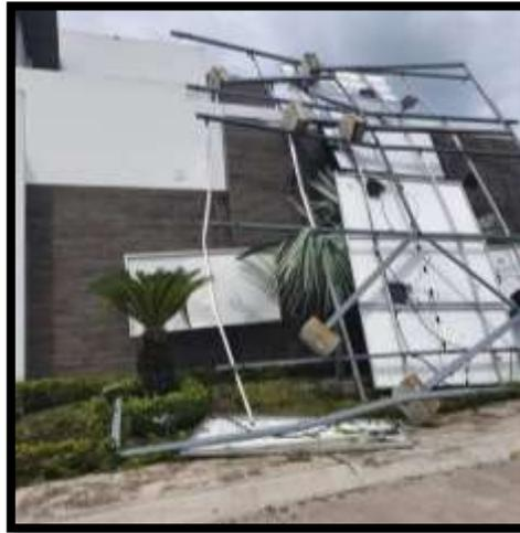
Figura 41 Pérdida total de un SFV por ráfagas de viento
