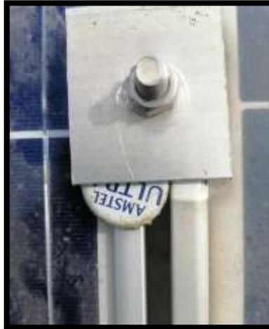
Figura 46 Error fatal de sistema puesta a tierra
