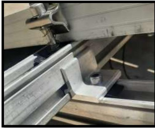
Figura 49 Uso correcto de los anclajes del módulo a la estructura
