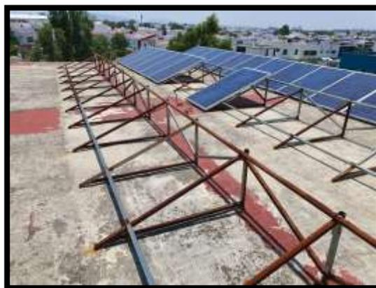
Figura 48 Estructura de PTR sin protección contra el par galvánico
