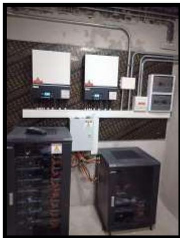
Figura 55 Sistema fotovoltaico autónomo
