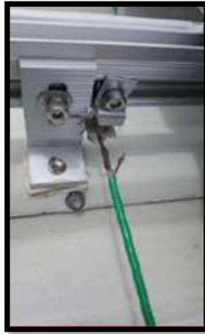
Figura 61 Fallo en el cálculo por expansión térmica
