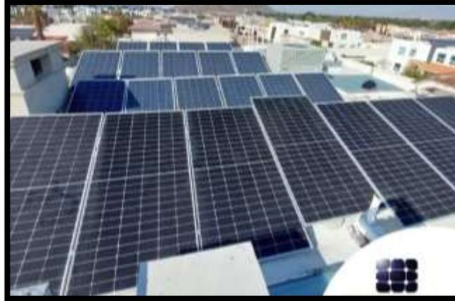
Figura 51 Incorrecto dimensionamiento de un SFVI
