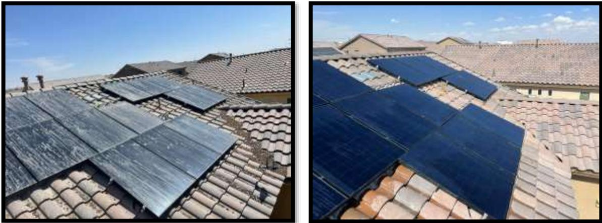
Figura 63 Correcta limpieza de los módulos en el techo
