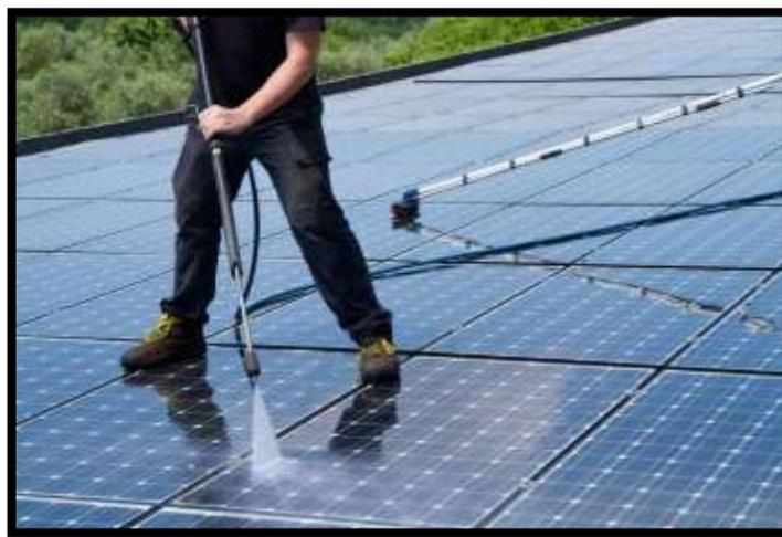
Figura 57 Incorrecto mantenimiento de un panel solar
