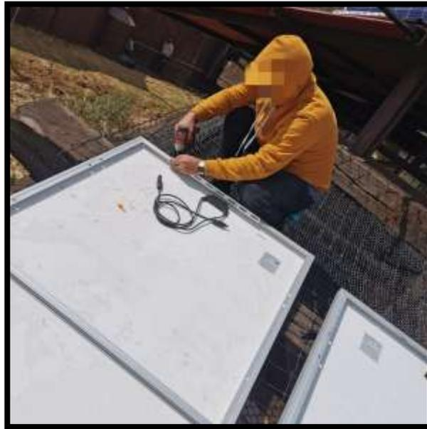
Figura 5 Generación de microfisuras por taladrar el módulo
