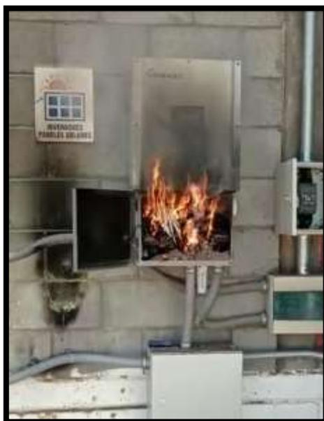
Figura 56 Incendio de inverter Growatt producido por un mal dimensionamiento
