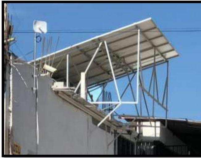
Figura 50 Diseño erróneo de SFV
