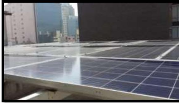
Figura 60 Incorrecta inclinación del SFV en el edificio de la lotería MTY
