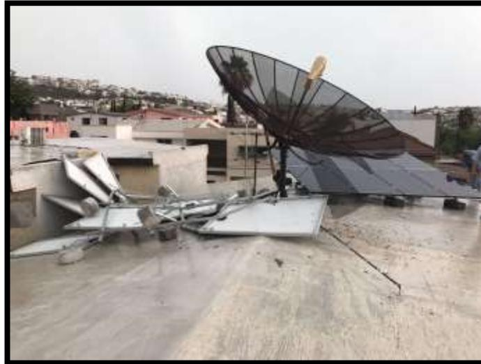
Figura 43 Anclaje ineficiente del sistema
