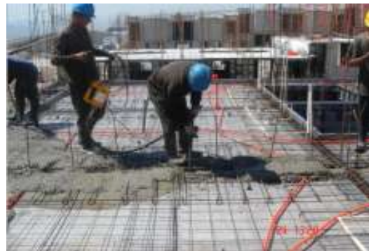
Figura 13. Vaciado y vibrado de concreto en la cimbra de aluminio. Training PDF elaborado por Ing. Jacobo Z. y segunda Figura por Line.17QQ.com
