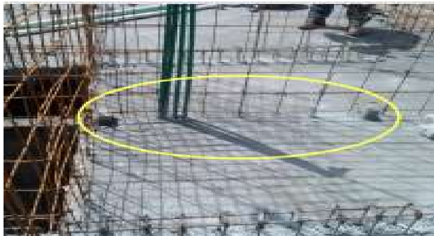
Figura 6. Colocación de acero de refuerzo al centro de trazo de muros. Fuente: Training PDF elaborado por Ing. Jacobo Z.
