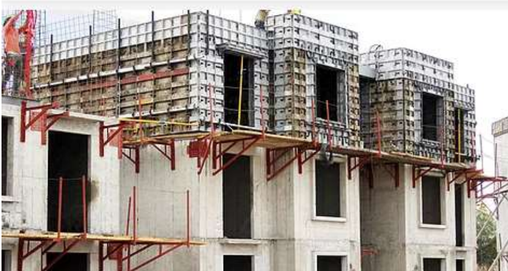
Figura 4. Cimbra de Aluminio para vivienda duplex de varios niveles. Fuente: https://www.westernforms.com/customers
