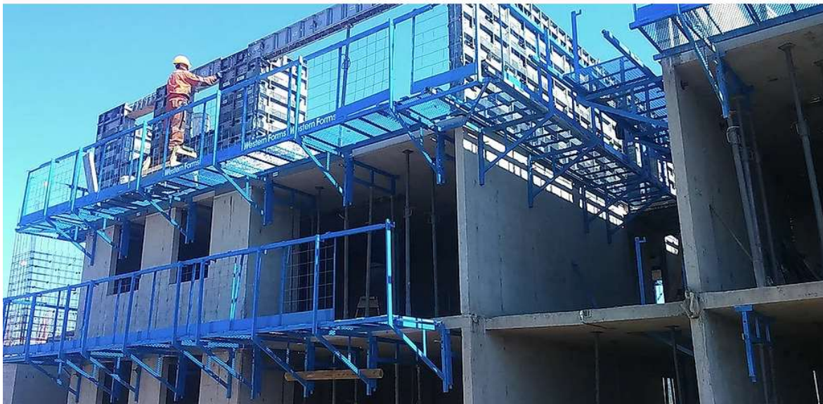
Figura 15. Andamios para fijación en formaletas de aluminio.
