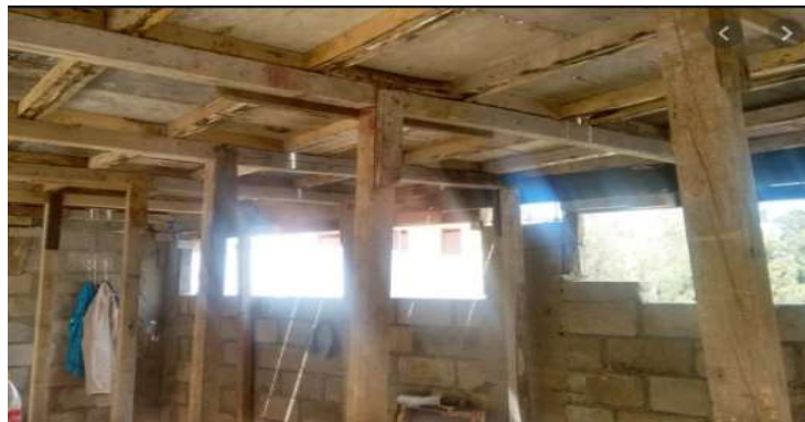
Figura 3. Cimbra de madera en losas Fuente:Habitissimo
