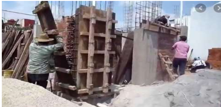
Figura 2. Cimbra de madera en castillos Fuente: optimiXADO
