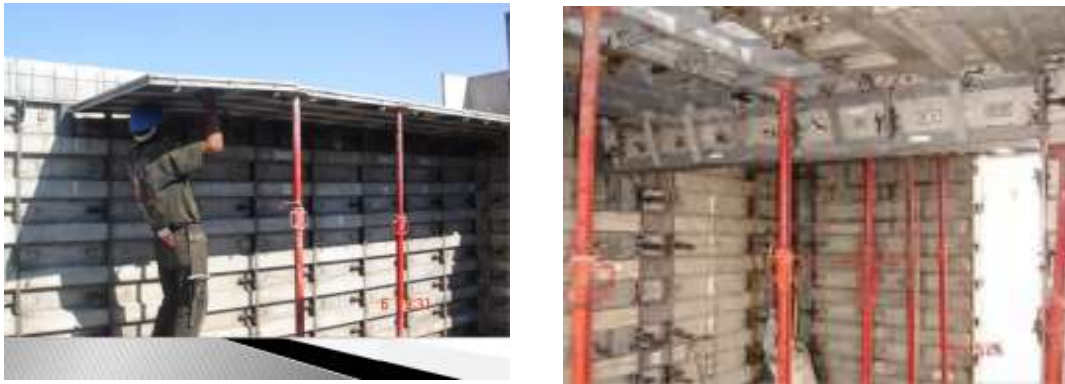
Figura 10. Colocación de cimbra de losa y distribución de postes. Fuente: Training PDF elaborado por Ing. Jacobo Z.
