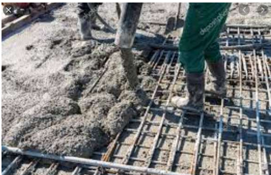
Figura 13. Vaciado y vibrado de concreto en la cimbra de aluminio. Training PDF elaborado por Ing. Jacobo Z. y segunda Figura por Line.17QQ.com
