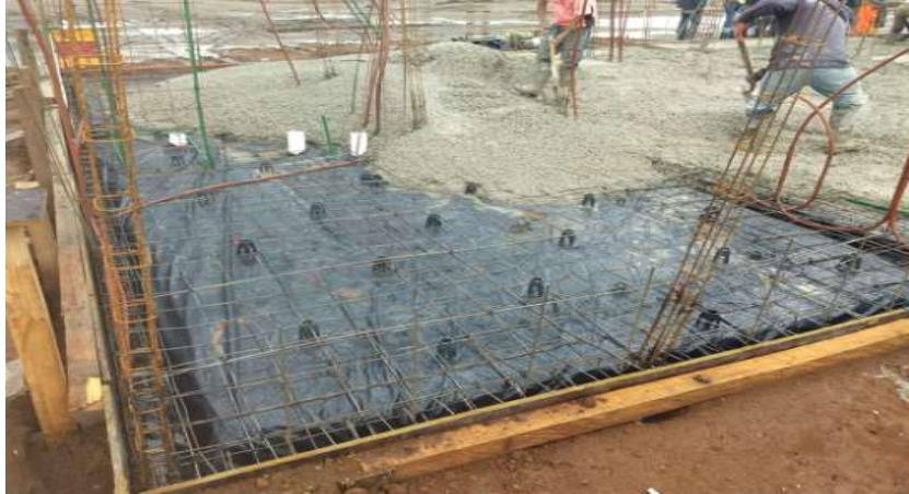
Figura 5. Colado de cimentación. Fuente: Habitissimo
