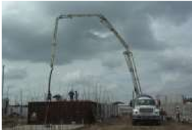
Figura 12. Vaciado de concreto por medio de bomba. Fuente: Training PDF elaborado por Ing. Jacobo Z.
