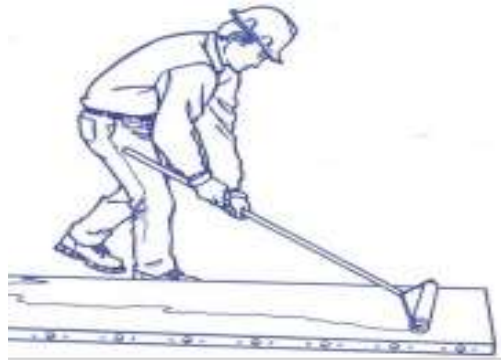
Figura 26. Aplicación de Desmoldante. Fuente: Training PDF elaborado por Ing. Jacobo Z.
