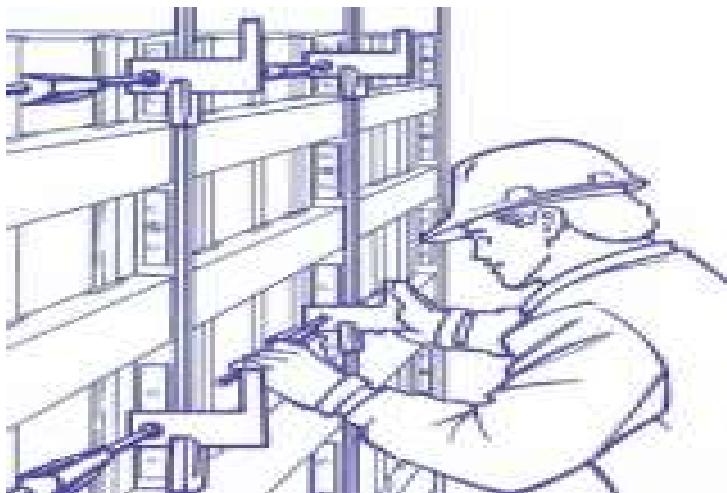
Figura 31. Colocación de soporte para alineadores de muro. Fuente: Training PDF elaborado por Ing. Jacobo Z.
