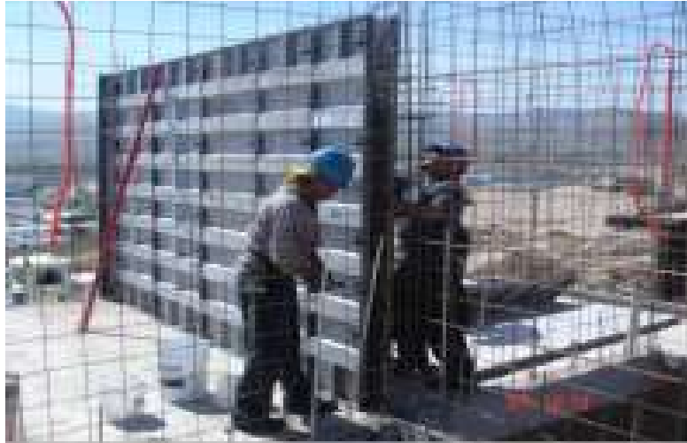
Figura 8. Colocación de formaleta de aluminio interior y exterior. Fuente: Training PDF elaborado por Ing. Jacobo Z.
