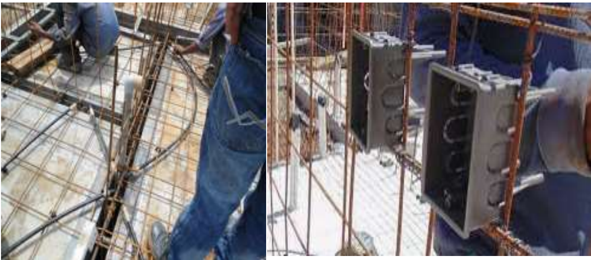
Figura 7. Colocación de instalaciones y accesorios eléctricos.
