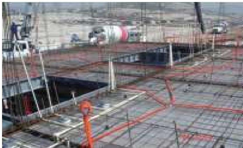
Figura 11. Colocación de acero de refuerzo e instalaciones en losa. Fuente: Training PDF elaborado por Ing. Jacobo Z.
