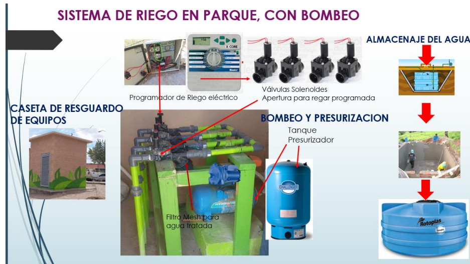
Figura 5.13 Prototipo de Equipo para Sistema de Riego en Obra de Captación
