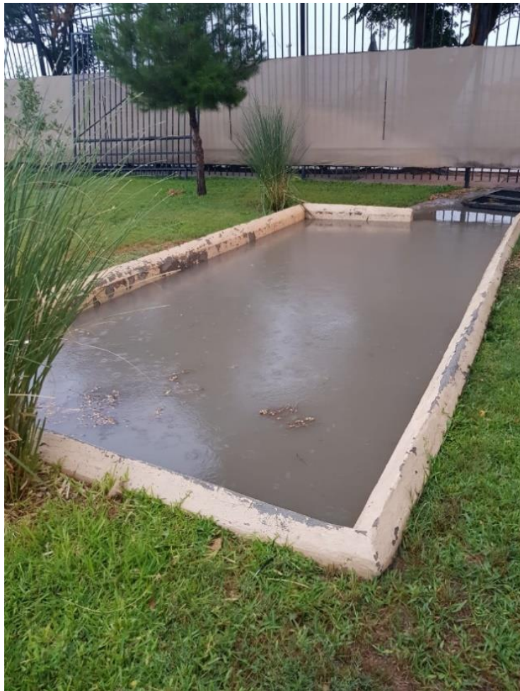
Figura 5.3 Fotografía del Pozo de Absorción de Parque La Joya
