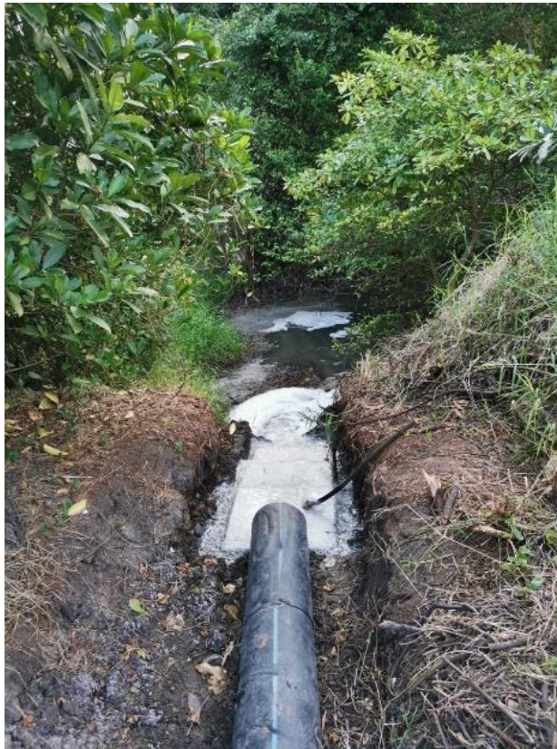
Figura 1. Descarga de aguas residuales domesticas en Arroyo Moreno.
