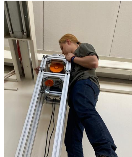
Figura 50: a) Corte de perfil de aluminio de 500 mm. b) Montaje del polipasto en la cabina.
