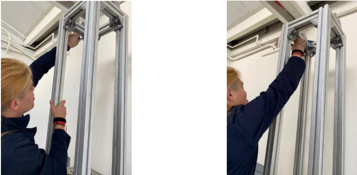
Figura 46: a) Preparación de la superficie donde sería montada la cabina. b) Reforzamiento de las uniones en la parte superior del banco de pruebas.
