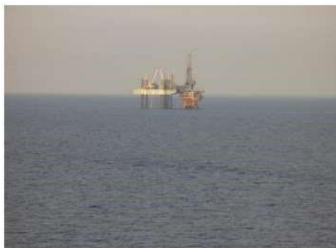
Ilustración 9. Plataforma de explotación.
