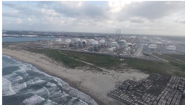
Ilustración 26. Refinería Dos Bocas, Tabasco.
