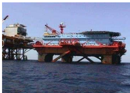
Ilustración 10. Plataforma de apoyo (Flotel)
