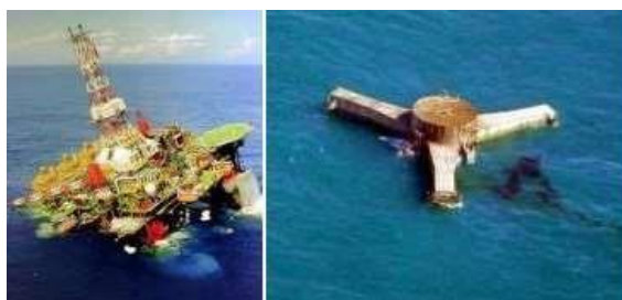
Ilustración 18. Accidente de la plataforma P-36 y de la falla de la mini- TPL Typhoon.
