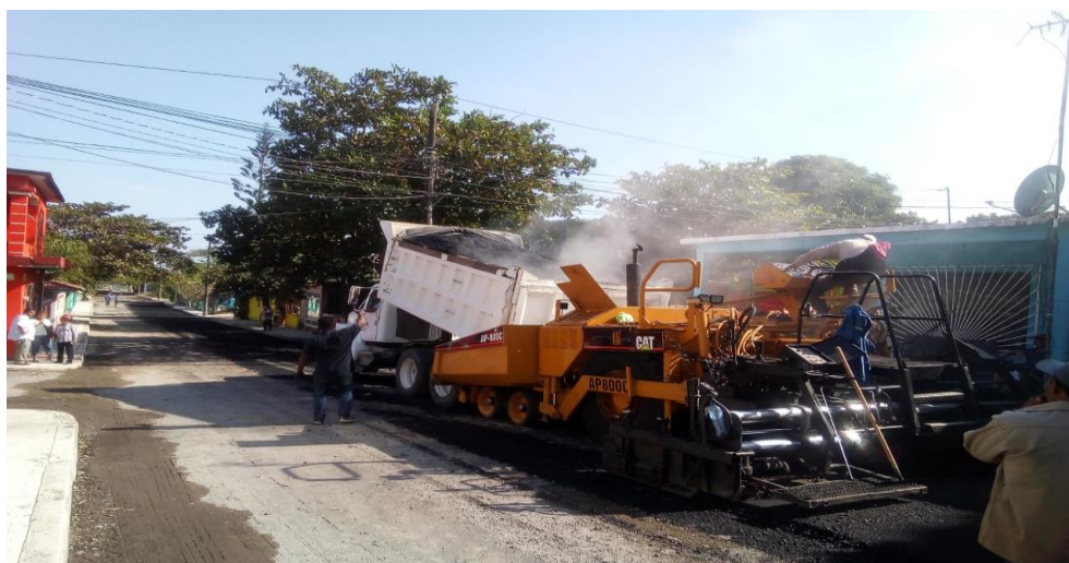
23 Colocación de asfalto.
