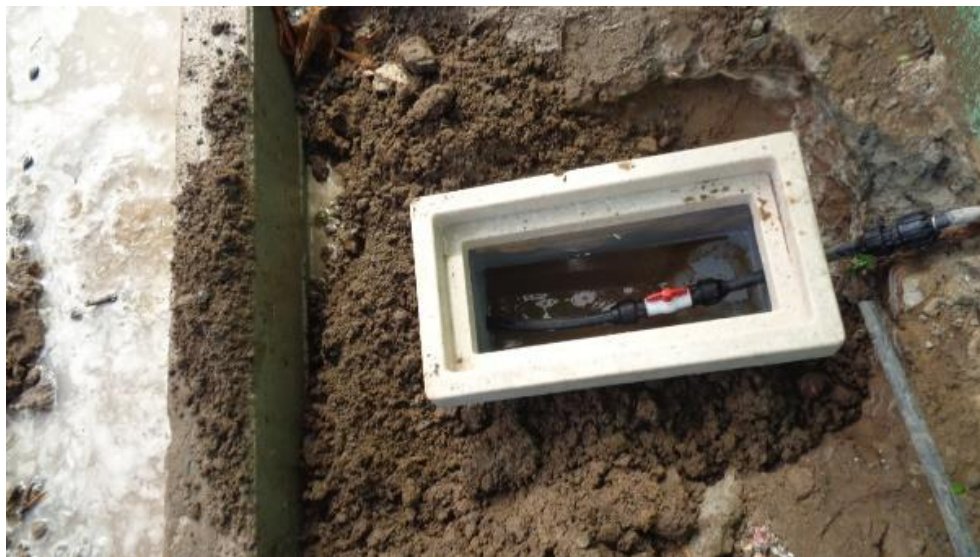
14 Colocación de registro de una toma domiciliaria.
