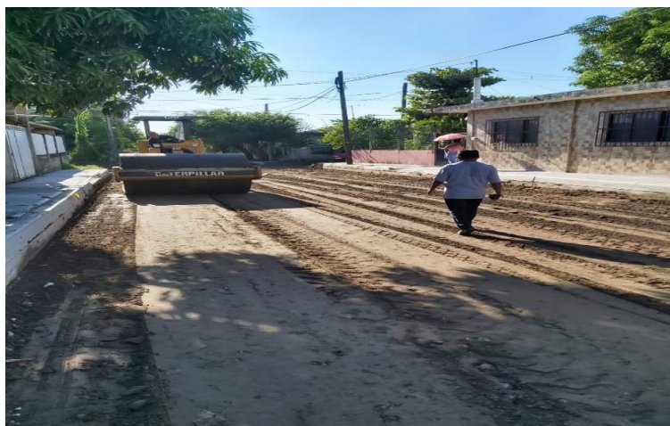
19 Compactación de la capa subbase
