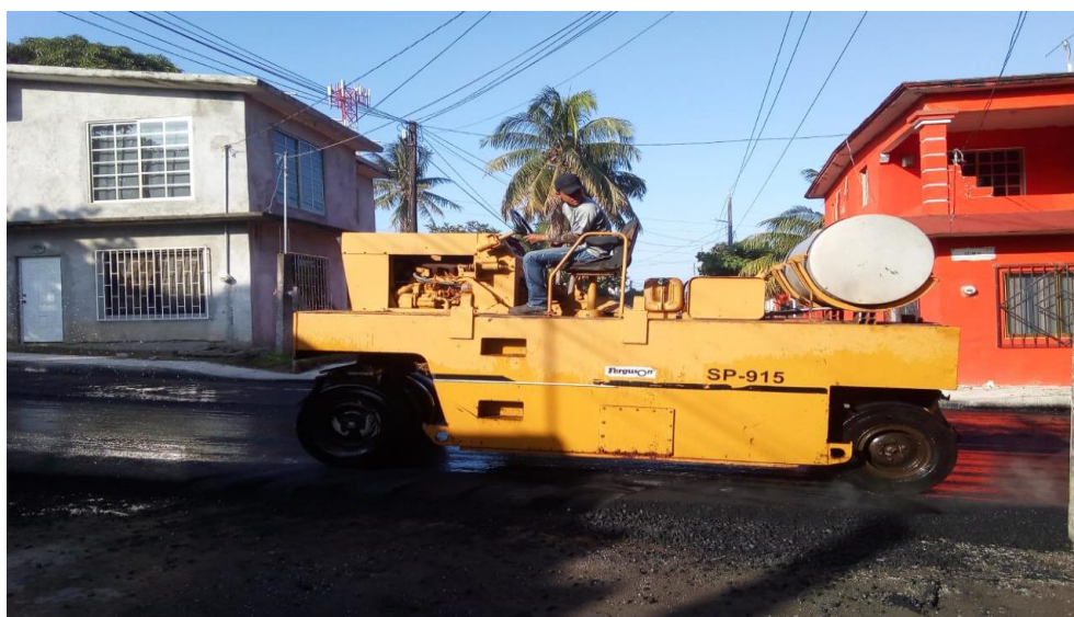
24 Compactación de asfalto.
