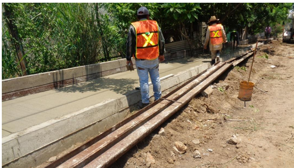
17 Acabado en banquetas.
