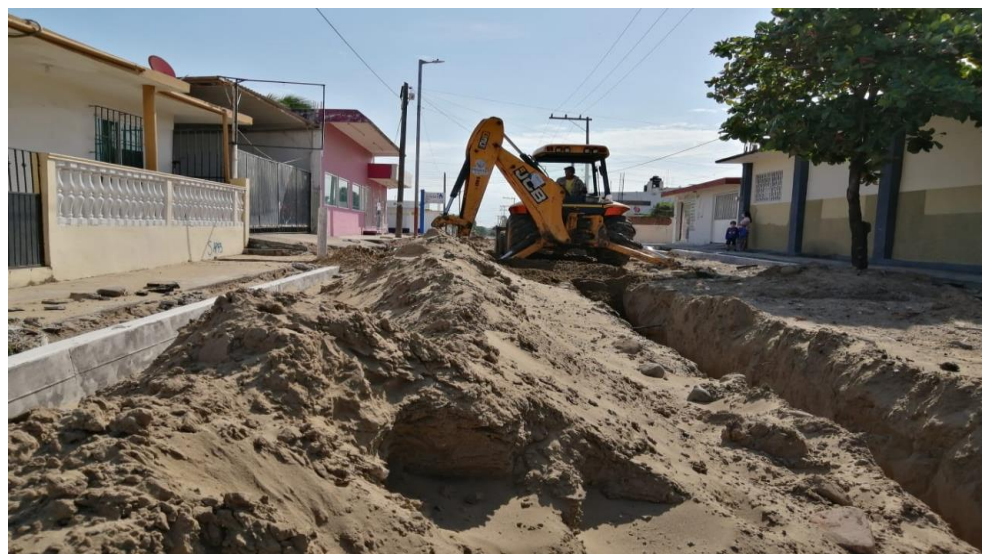
11 Suministro y colocación de relleno para tubería de drenaje.
