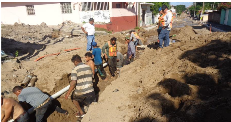
15 Suministro e instalación de tubería para agua potable.
