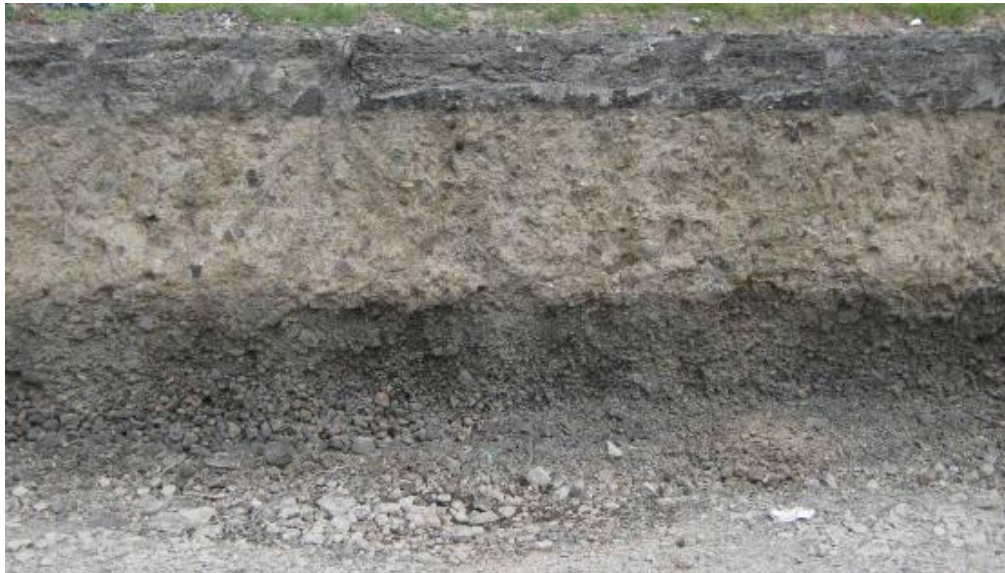
7 Capas que constituyen un pavimento.
