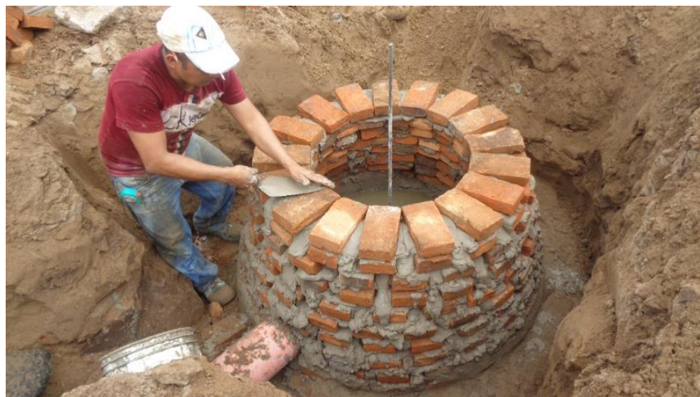
13 Construcción de un pozo de visita.
