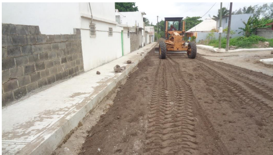
20 Tendido del material de base.
