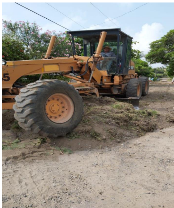
18 Despалme del terreno.
