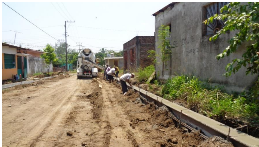
16 Colado en guarniciones.
