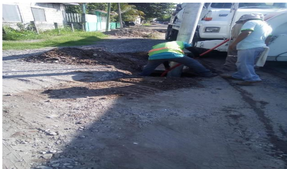
12 Sondeo de un pozo de visita.
