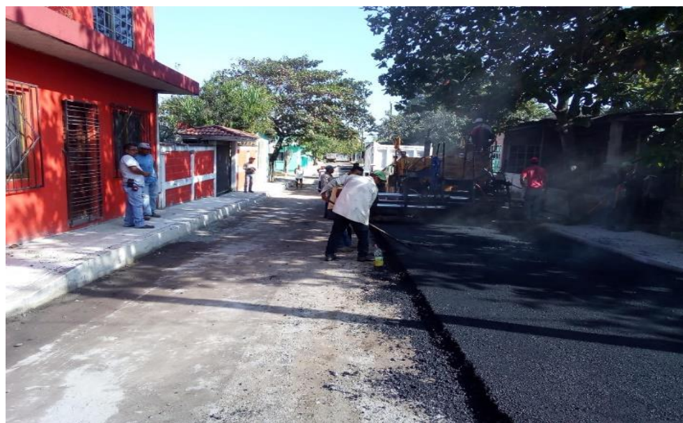
22 Tendido de asfalto.
