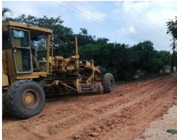
Fig. 30 Motoniveladora para la nivelación del terreno
