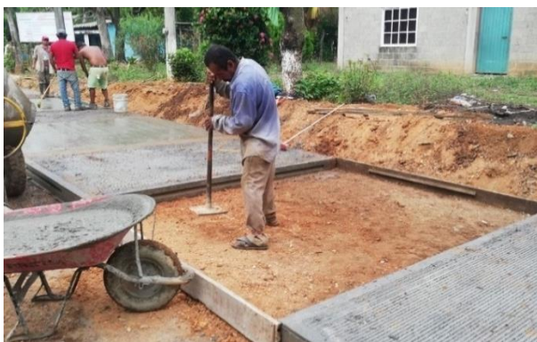
Fig. 32 Apisonado una masa de hormigón con pisón adecuado para una consistencia más firme
