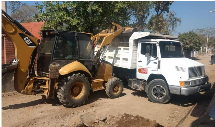
Fig. 20 remoción y limpieza de escombros con maquinaria pesada
