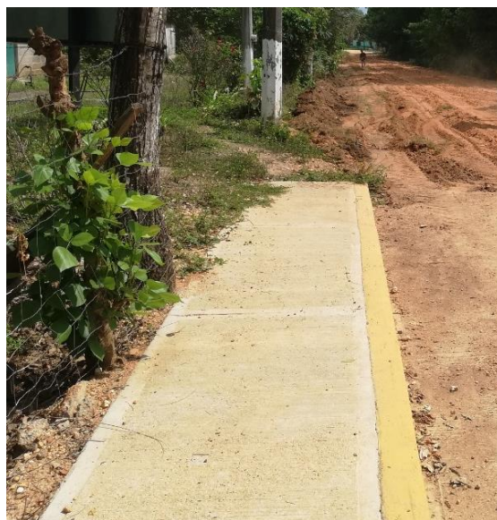
Fig. 42 Señalamiento horizontal en guarnición
