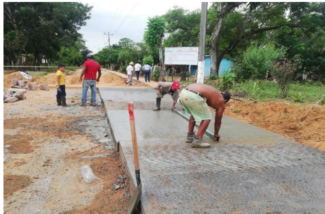
Fig. 38 Alisado de superficie de concreto hidráulico con regla metálica
