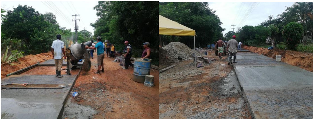
Fig. 37 Mezclado y Tendido de concreto hidráulico.
