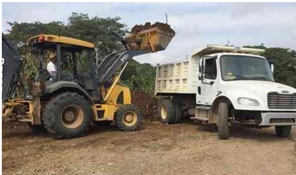
Fig. 36 Camión volteo para traslado de material producido por despalme
