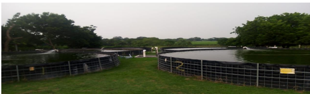
Figura 4. 38 Señalamientos en estanques.
